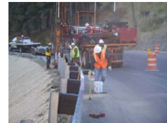
(Izquierda) Instalación de barandas de protección en Upper Squilchuck Road
