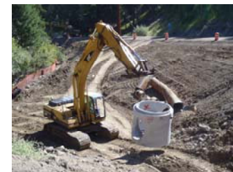
(Izquierda) Excavación en Upper Squilchuck Road
